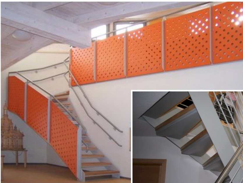
09 Flachstahlwangentreppe ¼ gewendet, Holzstufen
