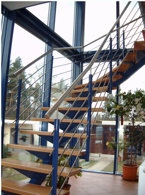
05 Mittelholmtreppe 1/4 gewandelt, Holzstufen
