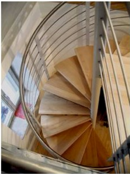
Spindeltreppe mit Podest, Holzstufen, Reilinggeländer mit Edelstahlhandlauf
