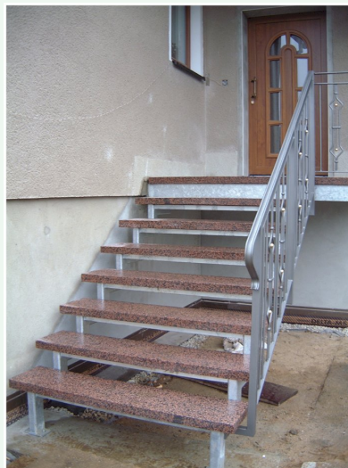
2-Holmtreppe mit Podest, Natursteinstufen, schmiedeeisernes Geländer feuerverzinkt
