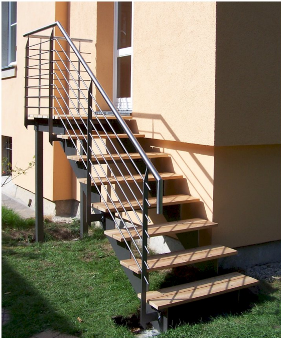
01 Gerade Wangentreppe mit Austrittspodest, Stufenbelag Bankirai, Stahl-Reelingeländer
