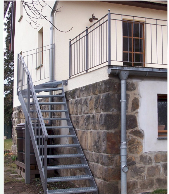
07 Flachstahlwangentreppe 1/4 gewendelt, Gitterroststufen, Stabgeländer, feuerverzinkt
