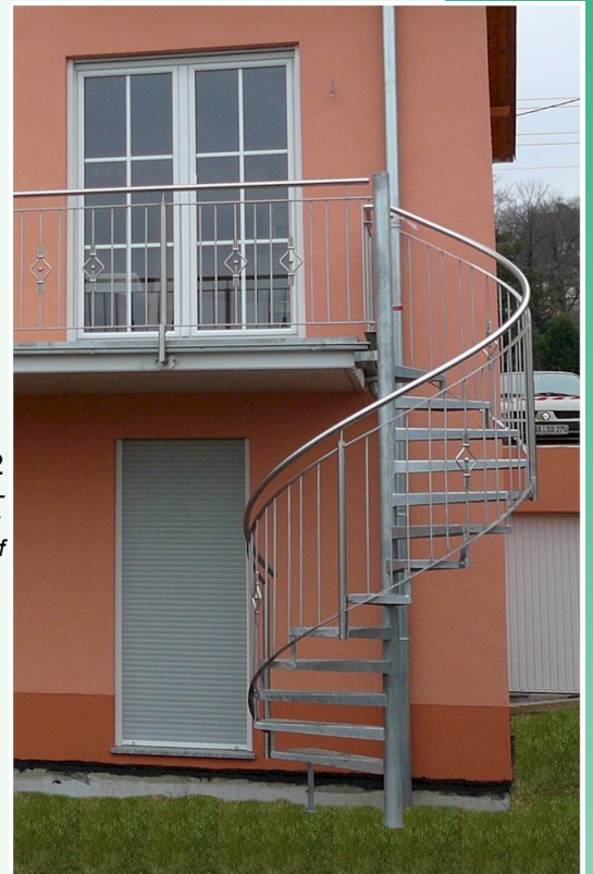
02 Spindeltreppe Gitterrost-Stufen, Stahlgeländer mit Edelstahlhandlauf
