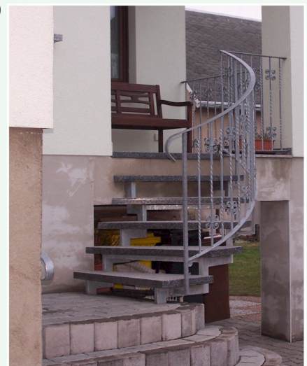
2-Holmtreppe 1/4 gewendelt, Natursteinstufen, schmiedeeisernes Geländer feuerverzinkt
