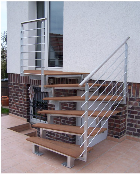
06 2-Holmtreppe 1/4 gewendelt, mit Austrittspodest, Stufenbelag Bankirai, Stahl-Reelingeländer, feuerverzinkt
